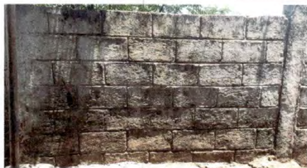
Foto 10: 9.1 Pintura en muros exteriores e interiores
