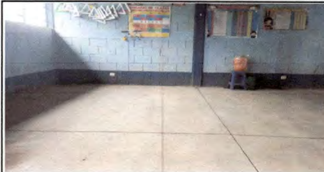
Foto 4: 6.8 Sustitución de piso cerámico
