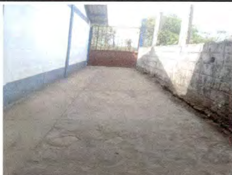
Foto 3: 6.6 Sustitución de piso de cemento liquido
