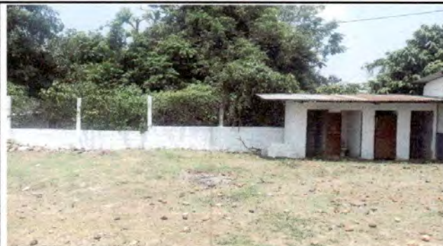
Foto 8: 9.1 Pintura en muros exteriores e interiores
