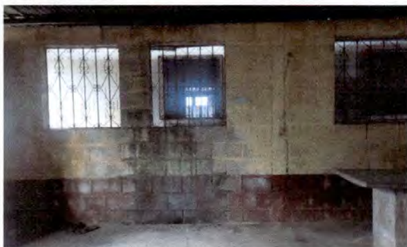
Foto 9: 9.1 Pintura en muros exteriores e interiores
