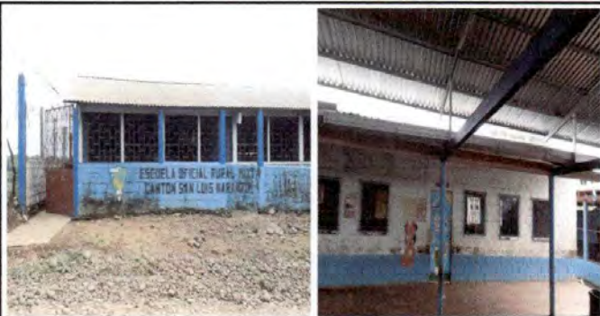
Foto 7: 9.1 Pintura en muros exteriores e interiores
