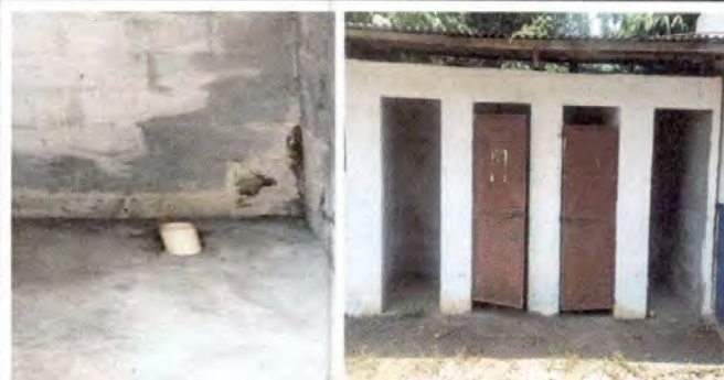
Foto 12: 19.15 Instalación de inodoro
