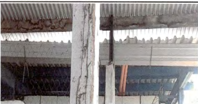
Foto 5: 7.4 Sustitución de bajada de agua pluvial de metal por tubo PVC 3"
