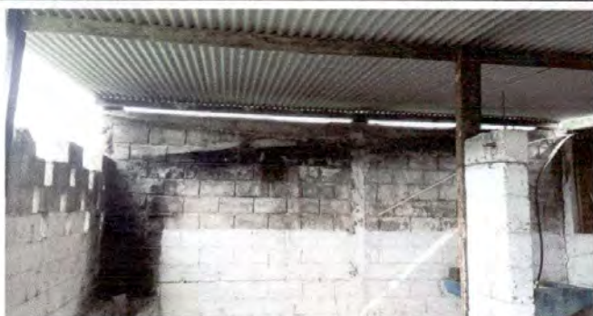
Foto1: 1.1 Sustitución de lámina, por lámina troquelada aluzinc calibre 26
