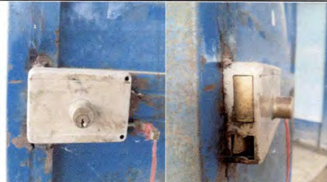
Foto 2: 4.2 Sustitución de Chapa
